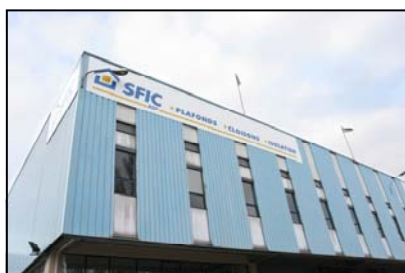
17 rue Montgolfier, 93110 ROSNY SOUS BOIS
